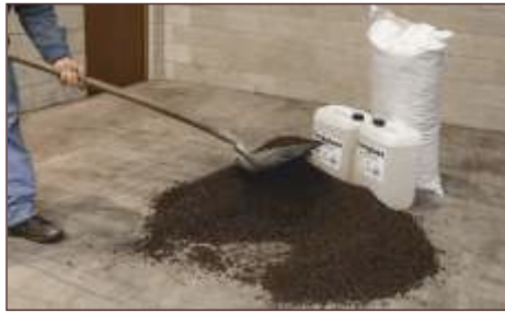
Miscelare 1 m 3 di CORKGRAN TOSTATO con 70kg di vetrificante CORKGLASS .
