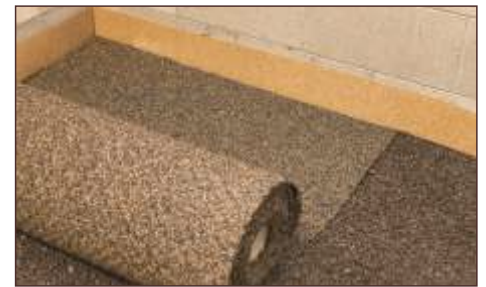
Disporre lo strato di isolamento acustico U32, U85 o COCCO PAV a tutta superficie.
