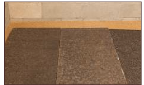
In caso di spessori elevati, posare CORKPAN
