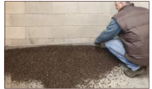
Stendere l'impasto e livellarlo con l'uso di una staggia.
