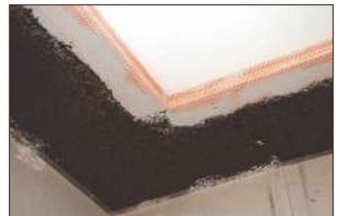
Posizionare i pannelli ben accostati, facendo aderire bene la colla al soffitto. Applicare tasselli a farfalla di sicurezza e provvedere alla rasatura con rete armata.
