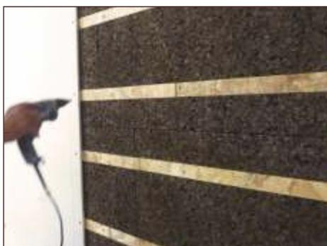
Rivestire tutte le superfici perimetrali, fissando il rivestimento scelto in corrispondenza dei listelli di OSB. Utilizzare tre viti autofilettanti per legno - tipo Fischer FSN-TPR - ben ripartite sulla lunghezza, per ogni listello. Per un miglior isolamento acustico applicare 2 lastre di cartongesso/fibrogesso, sfalsando la posizione dei giunti.
