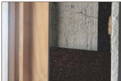
Se non è possibile utilizzare CORK-SELF, sagomare il pannello CORKPAN e procedere a posa e rasatura con il collante ADHEREVIT ecoCORK e rete armata.
