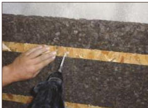
Fissare il pannello CORK-SELF alla parete utilizzando tasselli ad espansione idonei al tipo di supporto, nel numero indicato nella sezione «principali sistemi di fissaggio».
