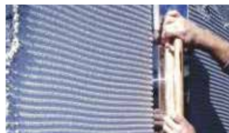
1. Stesura collante TECNOFIX MD sul supporto
