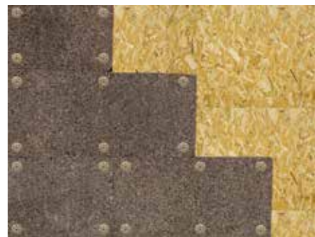
13. Dettaglio della posizione dei tasselli su legno
