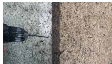
5. Fissaggio delle teste dei pannelli in prossimità degli spigoli dell'edificio
