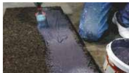
10. Applicazione della colla bituminosa sul pannello
