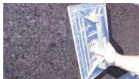
4. Verificare e correggere la planarità del rivestimento
