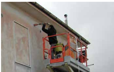
Insufflaggio eseguito dall'esterno.
