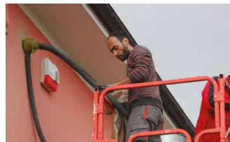
Caricato il granulato nell'apposito serbatoio, ha inizio l'insufflaggio.
