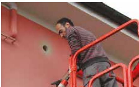
Realizzazione foro da 80mm.
