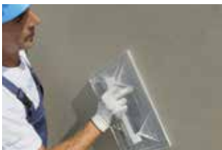
Spatolatura a talocchia della seconda mano
