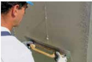
Applicazione della prima mano di REABILITA CAL
