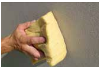
Spugnatura della superficie per un intonaco fine
