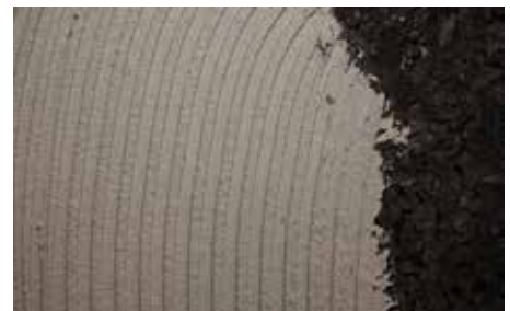
6. Applicazione primo strato di rasante TECNOFIX P10
