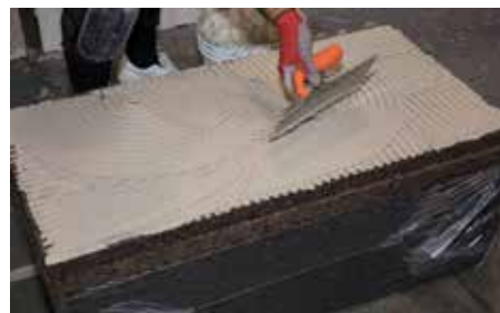
1. Applicazione del collante TECNOFIX P10
