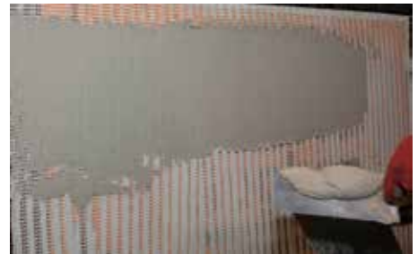
7. Applicazione del secondo strato di TECNOFIX P10
