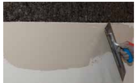
8. Applicazione del primo strato di CALCINA
