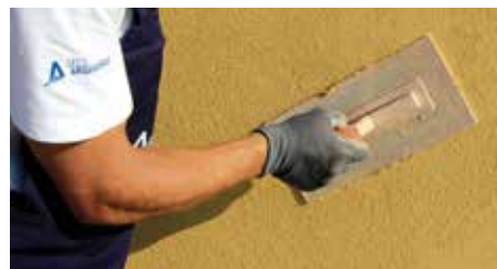
14. Applicazione della finitura a spessore
