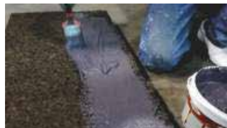
2. Applicazione della colla bituminosa sul pannello
