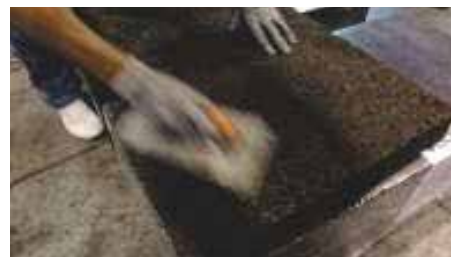
1. Creazione dello scasso per ospitare il collante bituminoso e lo spessore della guaina
