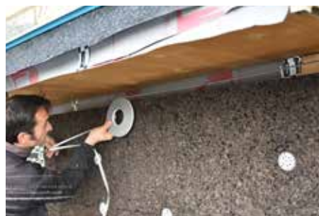
9. Applicazione del nastro espandente TECNOTAPE BG1
