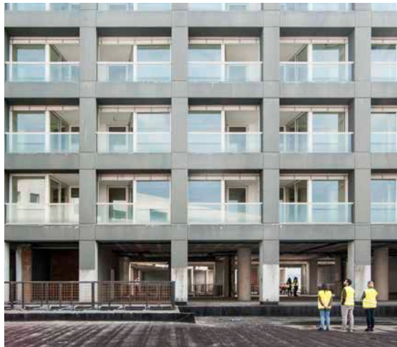
Visita a Technogym (a sinistra) Visita in cantiere (a destra)
