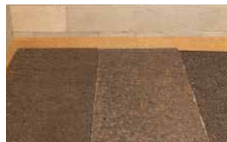
In caso di spessori elevati, posare CORKPAN
