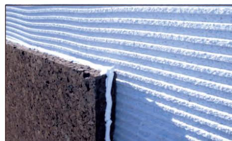
Applicare il pannello MD CORK FACADE tramite doppia spalmatura di collante ADHEREVIT ecoCORK MD.
