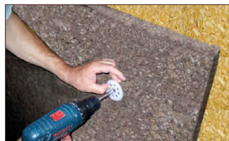
Utilizzando un avvitatore, fissare il primo strato di pannelli CORKPAN alla struttura.
