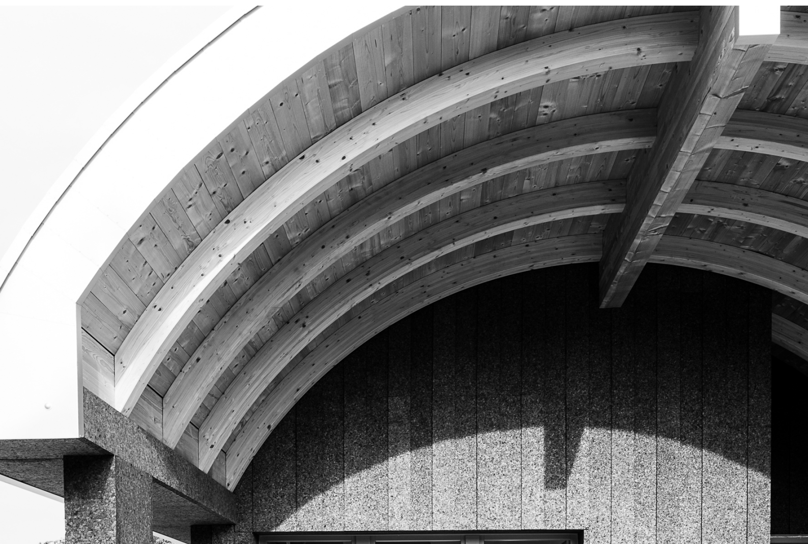
MFA rivestimento in Corkpan MD: dettaglio paramento esterno
