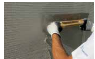
Stesura del secondo strato di malta
