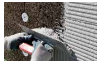
Stesura del primo strato di Isovit E-CORK
