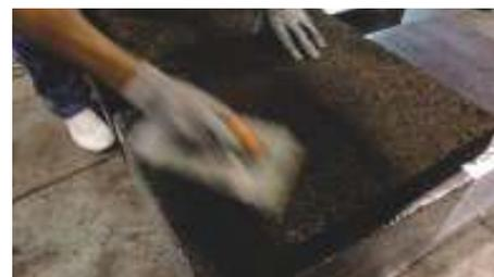
9. Creazione dello scasso per ospitare il collante bituminoso e lo spessore della guaina
