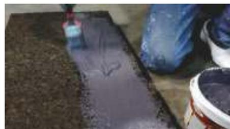
10. Applicazione della colla bituminosa sul pannello
