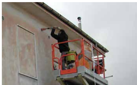
Insufflaggio eseguito dall'esterno.
