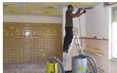
Insufflaggio eseguito dall'interno.
