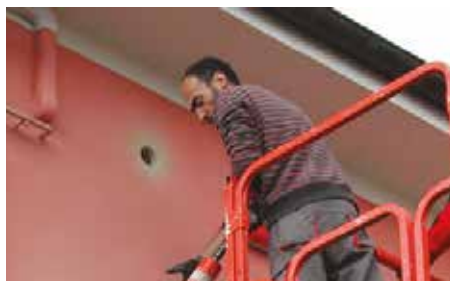
Realizzazione foro da 80mm.
