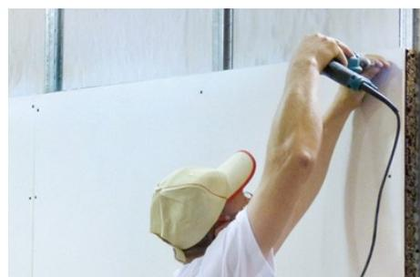
Corkges abbina i pannelli di sughero Corkpan alle lastre di cartongesso, con il risultato di avere un semilavorato già pronto all'uso. E' possibile abbinare al cartongesso qualsiasi spessore di sughero.
