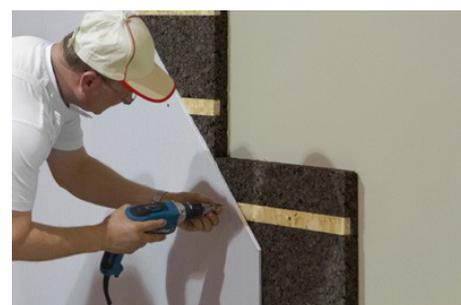
Cork-Self è la versione del pannello Corkpan con inseriti listelli OSB. Il pannello viene fissato a muro con colla cementizia e il rivestimento, sia esso cartongesso, legno o altro materiale, sarà poi fissato al sughero in corrispondenza dei listelli OSB, tramite viti.
