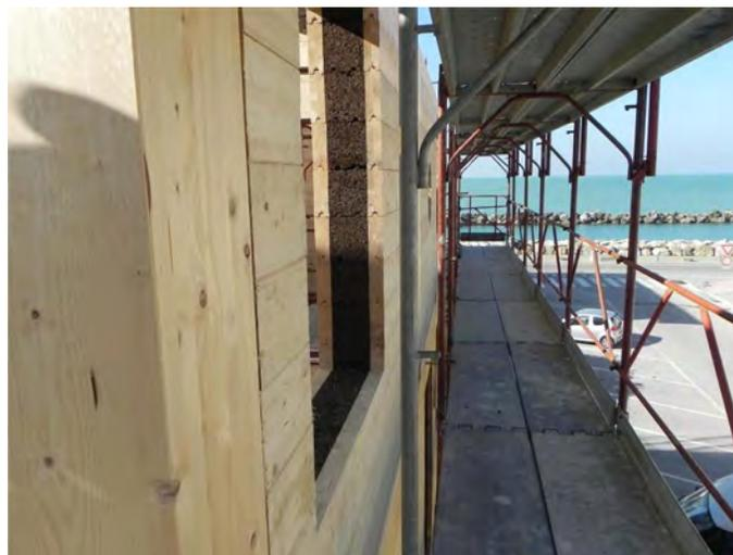
Seguendo lo schema di montaggio e rispettando la numerazione data in fabbrica, la posa in cantiere è immediata e senza rischi di errori.
