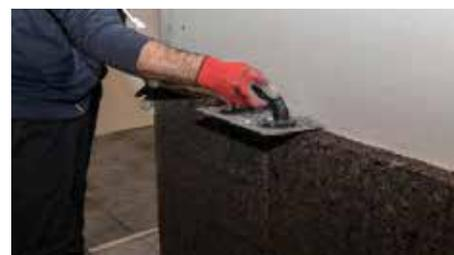
4. Dopo la posa di ogni pannello, verificare l'allineamento e la planarità delle superfici.
