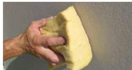
16. Spugnatura della superficie per ottenere un intonaco fine
