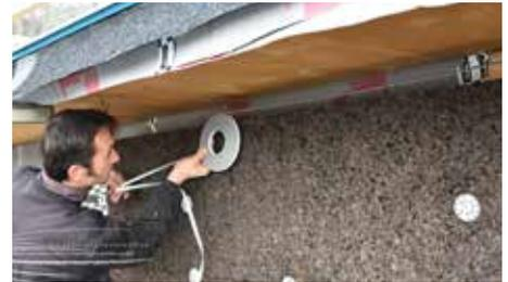
10. Posa del nastro espandente **TECNOTAPE** nei punti di contatto tra isolante e superfici rigide e sporgenti
