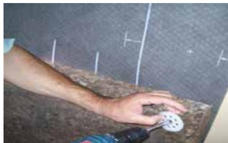
Partendo per file orizzontali e procedendo dal basso verso l'alto, fissare i pannelli fino a ricoprire interamente la struttura, con le stesse regole con cui si realizza il cappotto tradizionale. Verificare costantemente la planarità dello strato posato.
