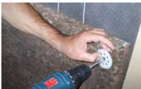
Applicare n. 6 viti a pannello con il seguente schema, stando circa 6-8 cm all'interno del pannello. Posizionare le viti circa 10cm all'interno pannello.
