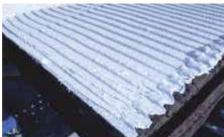
Procedendo per file orizzontali e dal basso verso l'alto, fissare i pannelli fino a ricoprire interamente la struttura.
