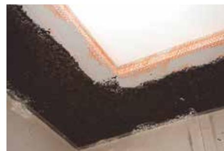
Se non è possibile utilizzare CORK-SELF, sagomare il pannello CORKPAN e procedere a posa e rasatura con il collante ISOVIT E-CORK e rete armata.
